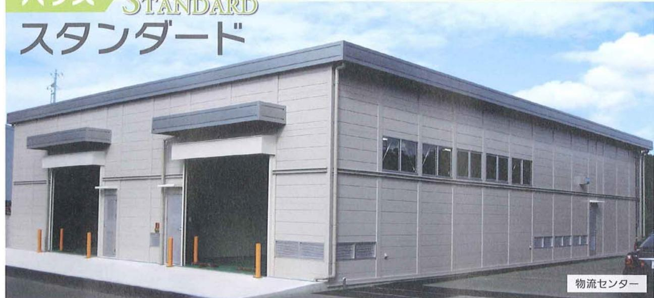
カラー鋼板の間にノンフロンの硬質ポリウレタンフォームを注入することにより発泡時に強力な自己接着力が生まれ、両サイドのカラー鋼板の隅々に浸透した機密性の高いサンドイッチパネル。
